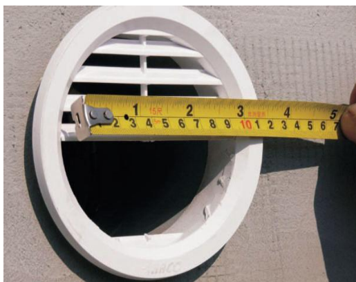
správně vylámané lamely plastové koncovky
